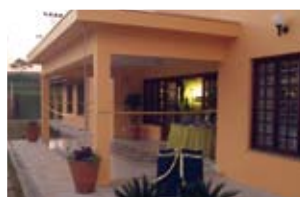
Sede Regional e Centro de Convivência (R$ 159.629,60) - conclusão das obras do salão de festas - recuperação das piscinas, com instalação de gradil e paisagismo
