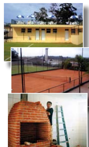
Centro de Convivência (R$ 21.817,48) - finalização das obras de construção (geral)
