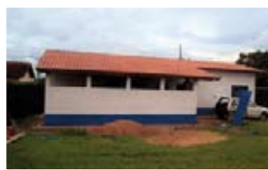
Centro de Convivência (R$ 23.599,21) - recuperação do gramado, alambrado, casa do caseiro e alambrado da piscina - pinturas das diversas instalações
